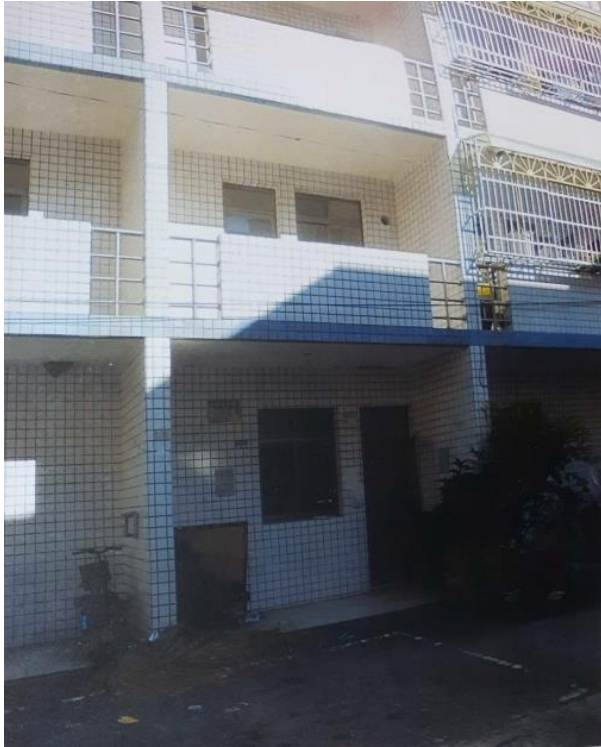
圖 1:屏東縣新埤鄉新民路 41 巷 27 號之連棟三層住宅
