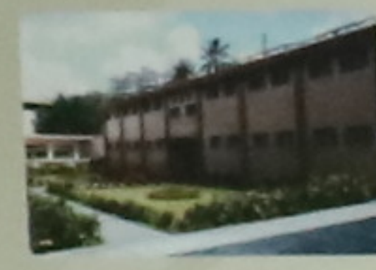
明德樓辦公廳舍 整修工程竣工 2002年12月16日
