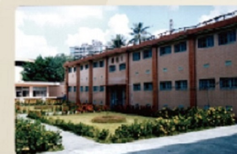
明德樓辦公廳舍 整修工程竣工 2002年12月16日
