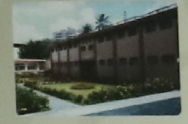
明德樓辦公廳舍 整修工程竣工 2002年12月16日
