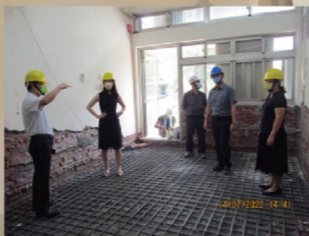
· 分署長視察施工現場
