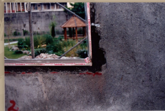
· 舊時建物今屏起樓檔案室整修，窗外望出一景
