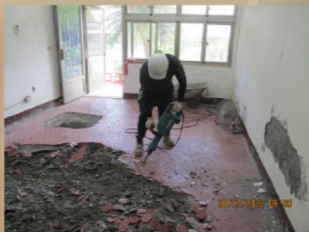
· 敲除地面老舊磁磚
