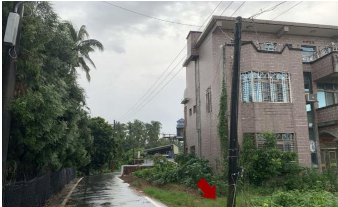
屏東分署法拍營造公司位於長治鄉的 219 坪建地，第三人建物不在本次拍賣範圍之內
